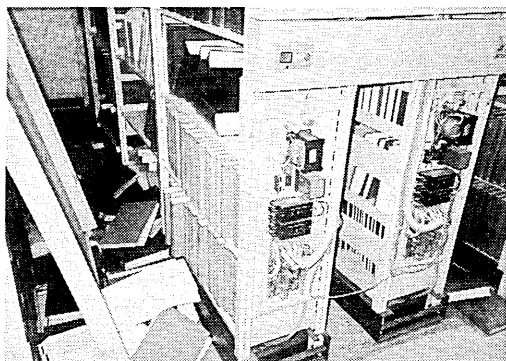
写真2: スタックランナー部品破損
